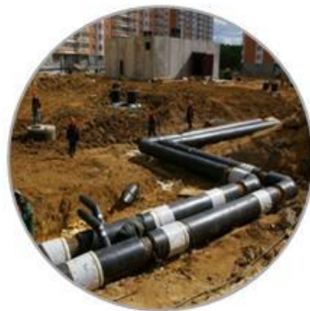
Прокладка инженерных сетей
