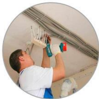
Монтаж внутренних коммуникаций
