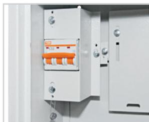
Отдельная рейка с пломбирочной панелью для вводного автомата.
