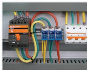
Большое количество точек подключения с возможностью использования проводников с наконечниками и без них, а также с возможностью визуальной проверки присоединения кабеля.
