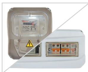
Возможность визуального контроля за показаниями счетчика и состоянием модульных аппаратов.
